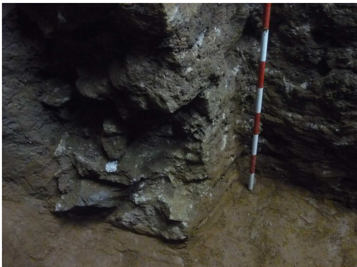
Sondeig 3. Detall del mur UE 322
