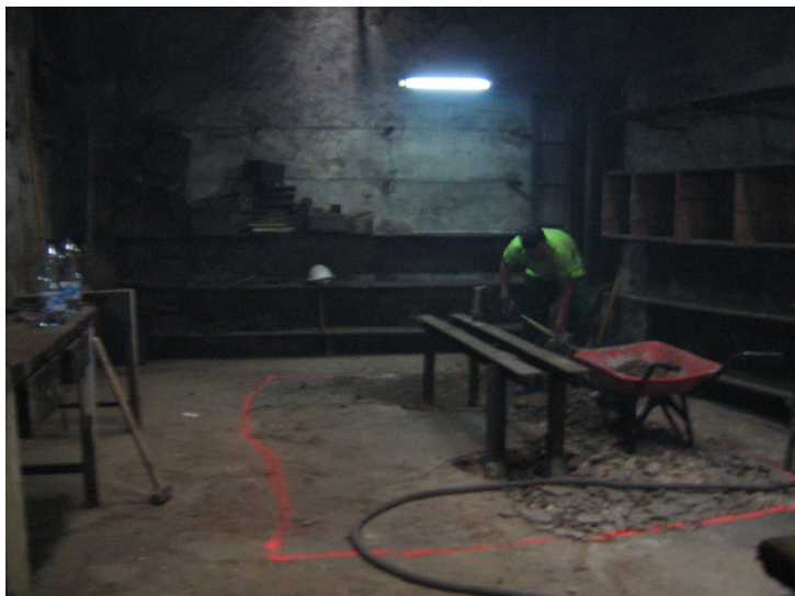
Sondeig 7. Delimitació i inicis dels treballs d'excavació.
