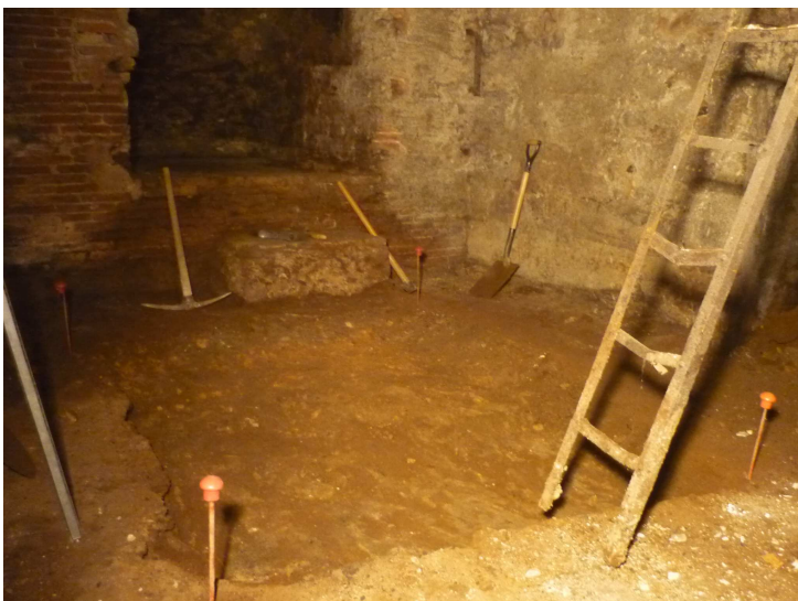
Sondeig 2. Delimitació i inicis dels treballs d'excavació.
